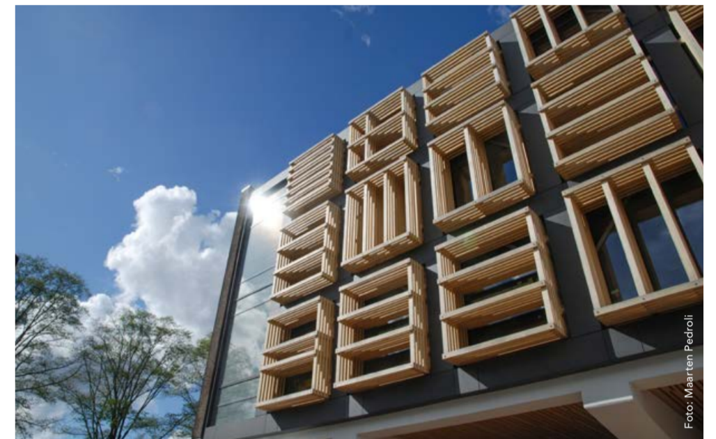
Gebouw 027E uit 1962, ontworpen in de stijl van Le Corbusier
