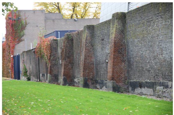
Afb. 3. Monumentale 17de-eeuwse muur die het Marineterrein afsluit.
